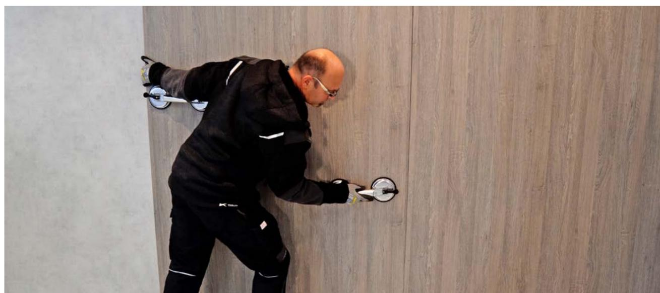
RESOPAL SpaStyling Boards lassen sich mit handelsüblichen Werkzeugen direkt vor Ort wie ein üblicher Holzwerkstoff be- und verarbeiten. Das RESOPAL SpaStyling Board kann bei Neubau- und Renovierungsobjekten direkt auf vorhandene Fliesen oder andere Untergründe geklebt werden. Die schnelle, einfache und saubere Montage sorgt für wenig Schmutz und geringe Ausfallzeiten der Räume.
